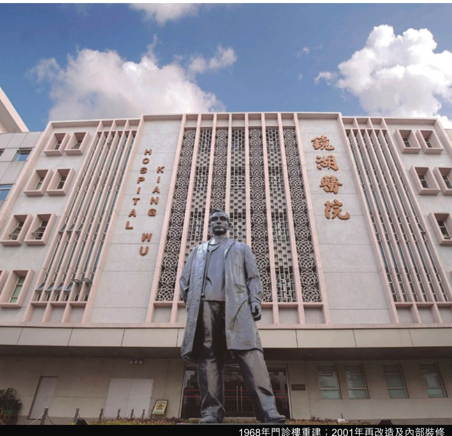
1968年門診樓重建；2001年再改造及內部裝修
